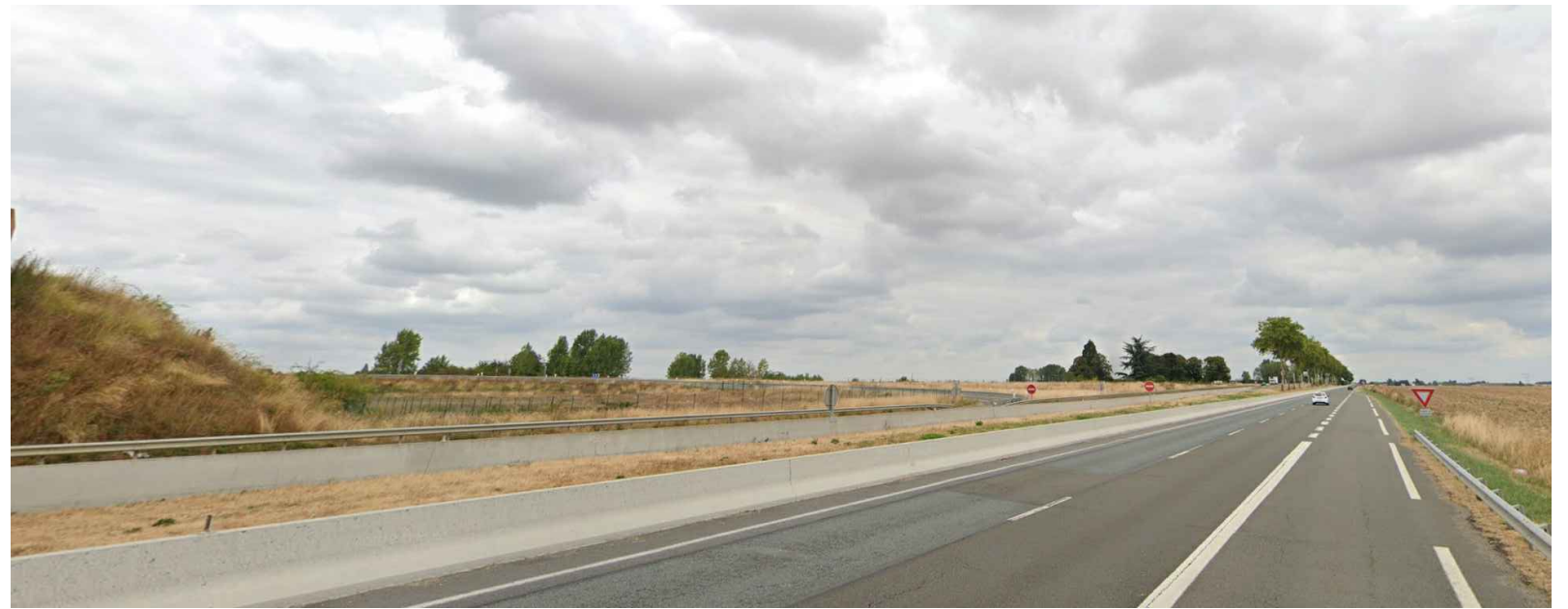
3. VUE DEPUIS LE PONT D136B
